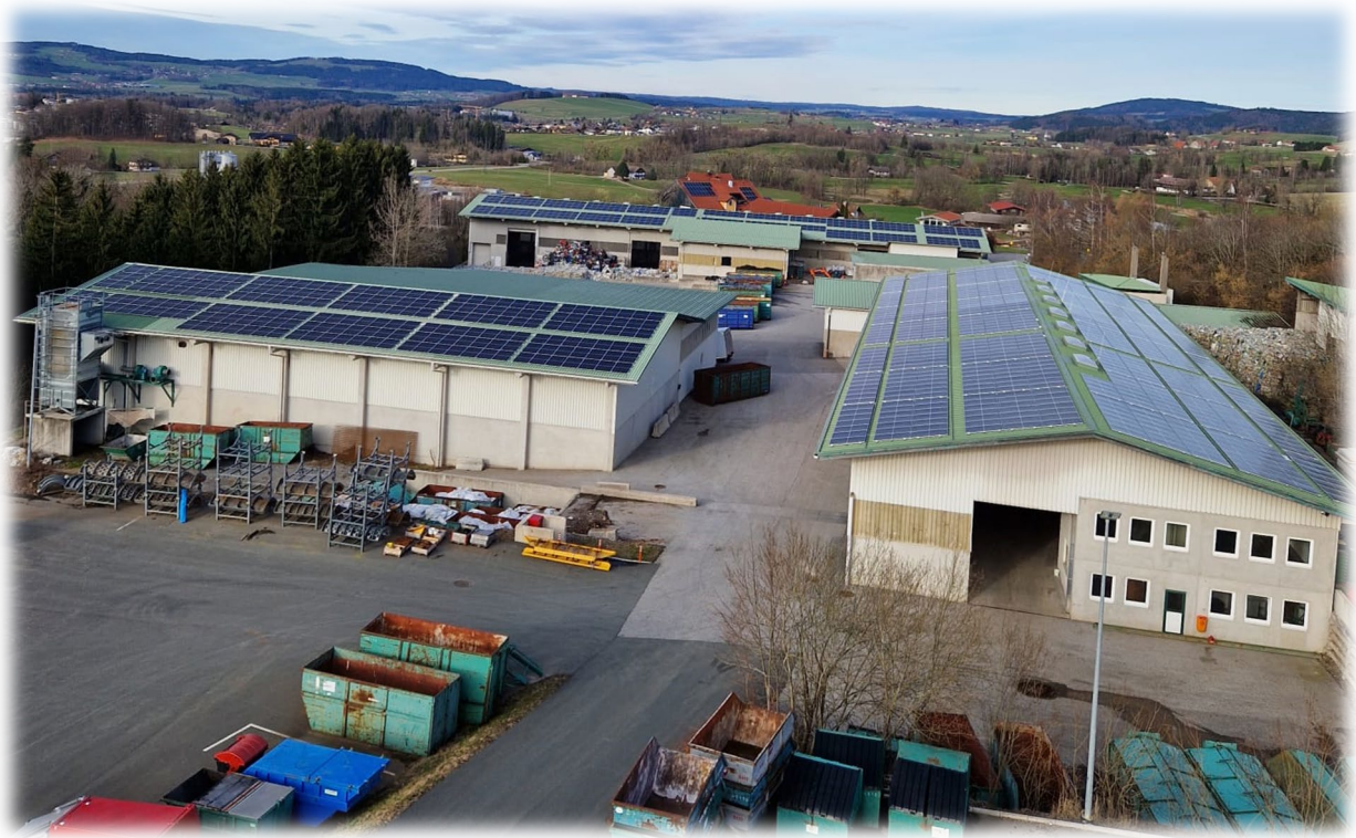
Photovoltaikanlage auf den Hallendächern
