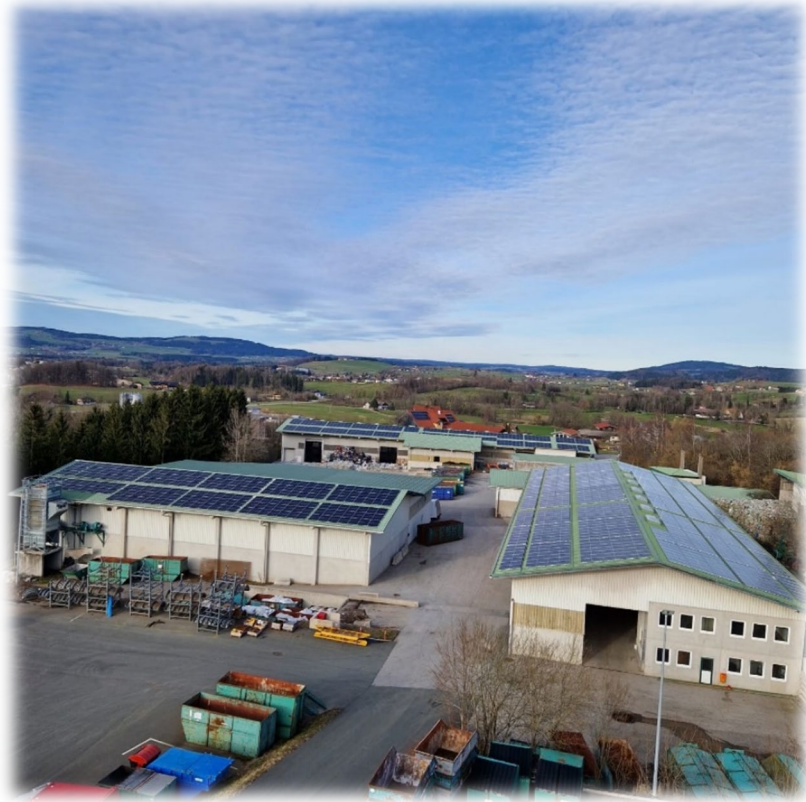
Ansicht von oben auf den Standort der Struber Recycling GmbH
